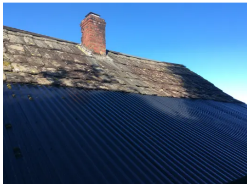
Dels skifertekking, dels metallplater.
