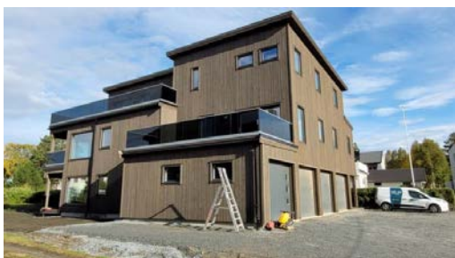
Terrasse oppført utenfor fasade sørvest.
