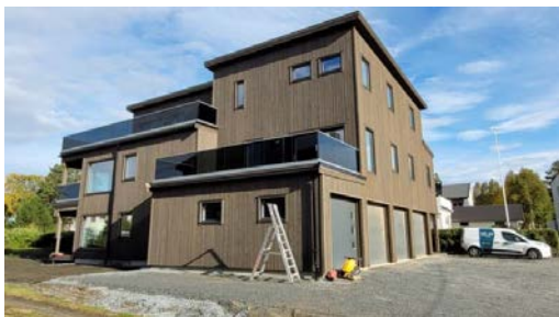
Terrasse oppført utenfor fasade sørvest.
