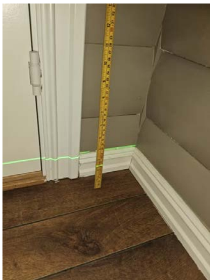
Bilde viser måling av etasjeskiller.
