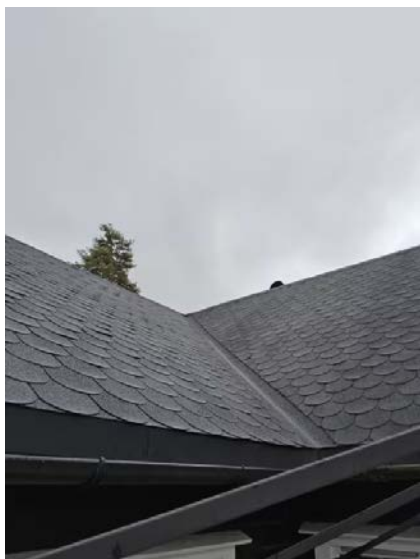
Bilde viser taktekking.
