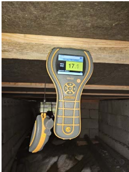
Bilde viser fuktmåling i krypkjeller.
