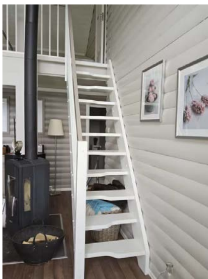
Bilde viser trapp med manglende håndløper.
