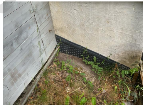
Kontroll av drenering/fuksikring.
