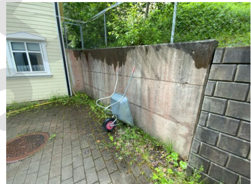
Besiktigelse av støttemur.
