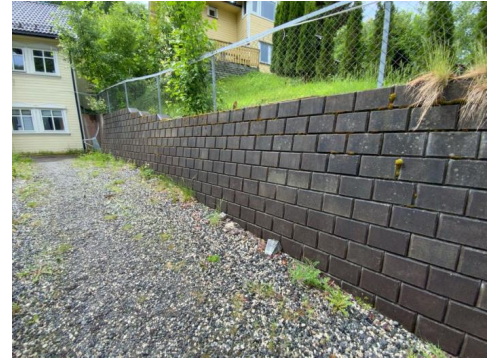
Besiktigelse av støttemur.
