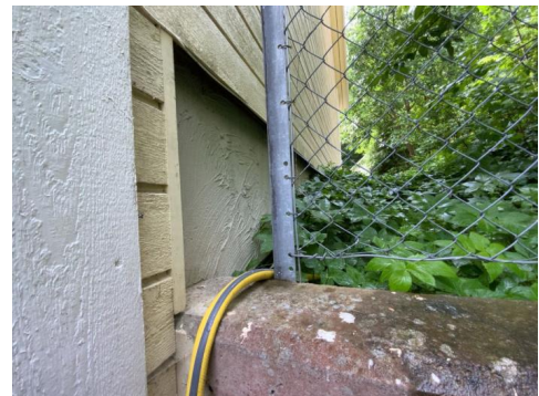
Kontroll av drenering/fuksikring.
