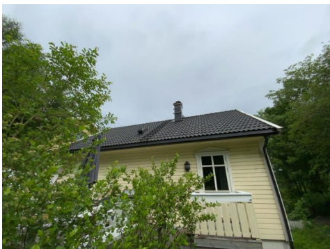
Besiktigelse av taktekke.
