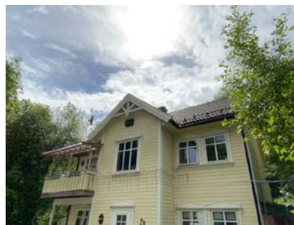
Besiktigelse av taktekke.
