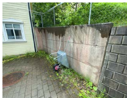
Besiktigelse av støttemur.
