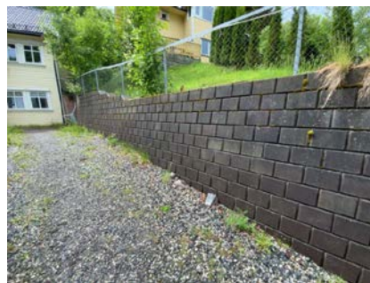
Besiktigelse av støttemur.
