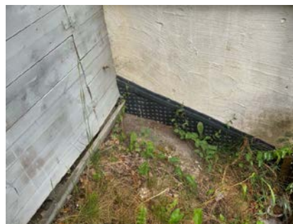
Kontroll av drenering/fuktsikring.
