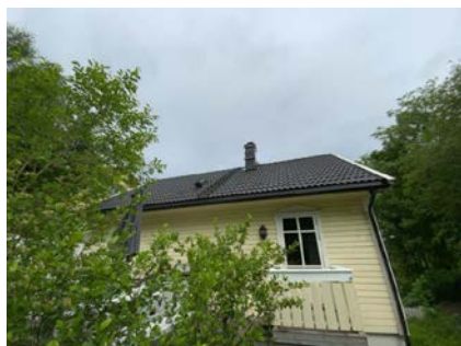
Besiktigelse av taktekke.
