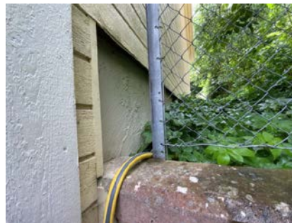
Kontroll av drenering/fuktsikring.
