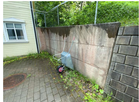
Besiktigelse av støttemur.
