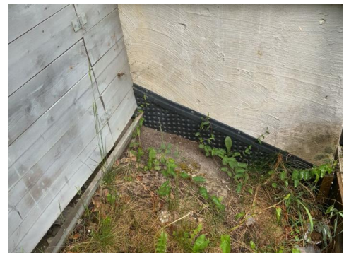
Kontroll av drenering/fuksikring.
