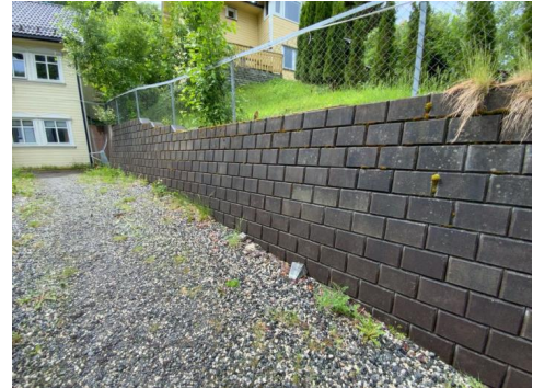
Besiktigelse av støttemur.
