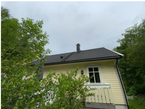
Besiktigelse av taktekke.
