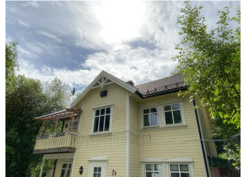
Besiktigelse av taktekke.
