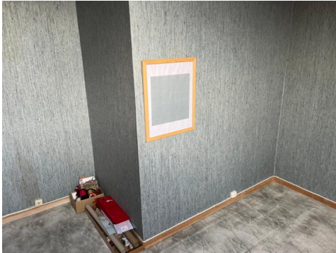
Pipe bygget inn. Luke bak bilde på vegg.
