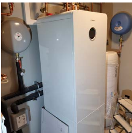
Varmepumpe for bergvarme.
