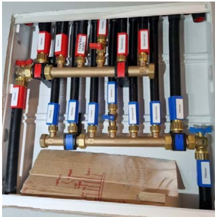
Rør-i-rør opplegg
