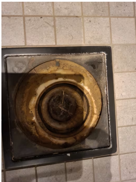
Membran er synlig klemt med klemring til sluk.
