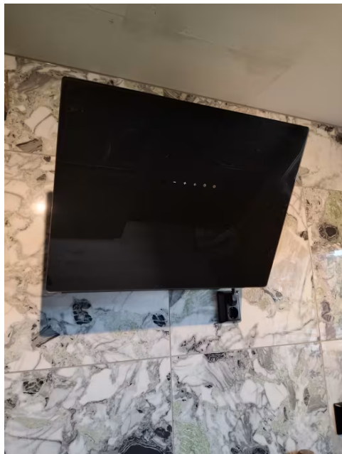
Vegghengt kullfilterventilator.
