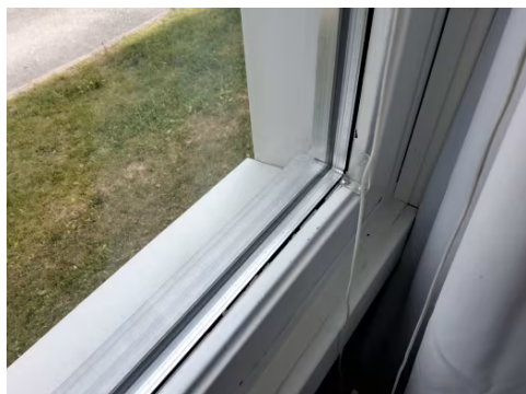
Leiligheten har vinduer med to-lags glass.
