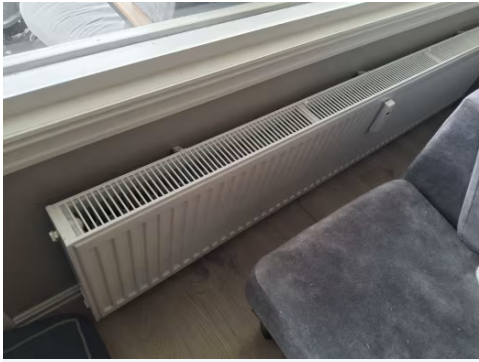
Det er skiftet en radiator på stue.
