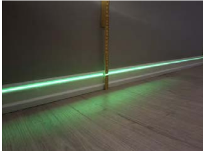
Etasjeskille ble kontrollert med nivelleringslaser.
