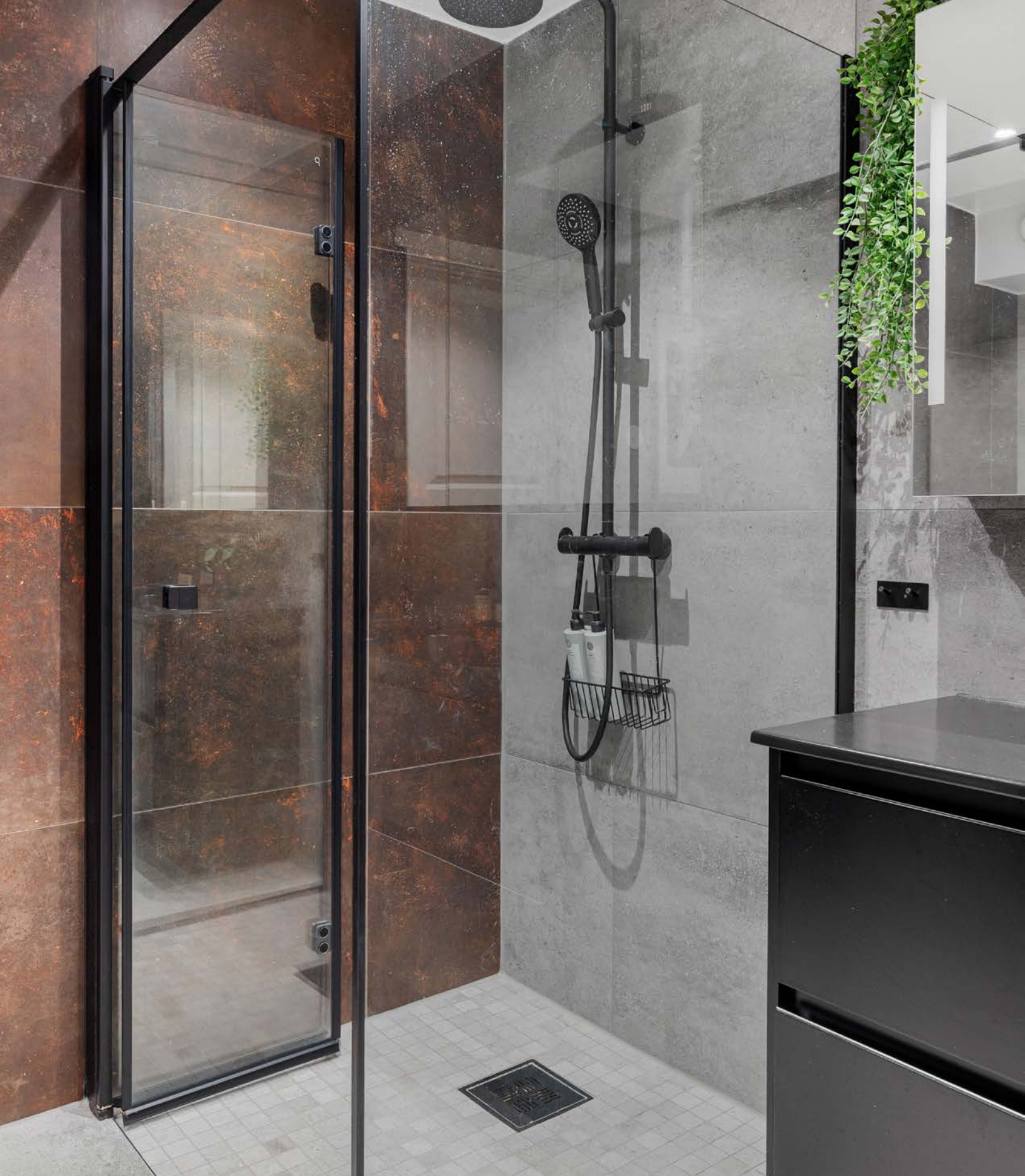
Dusjhjørne med nedsenket gulv og dusjdører. Veggmontert dusjbatteri med regnfall.
