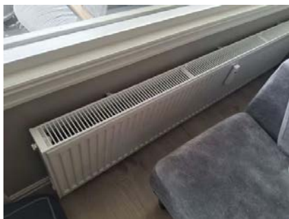
Det er skiftet en radiator på stue.
