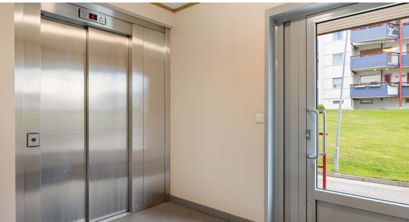
Det er heis i bygget som også går ned i kjelleren hvor det er bod på ca. 4 m 2 .
