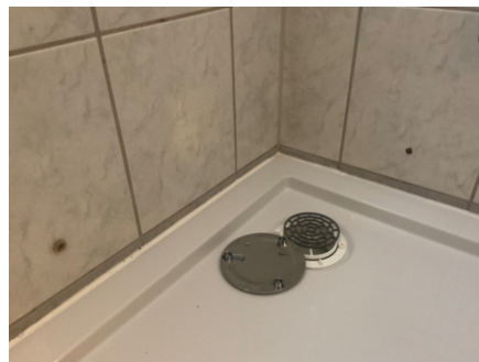
Plugg hull på vegger i dusjsone.
