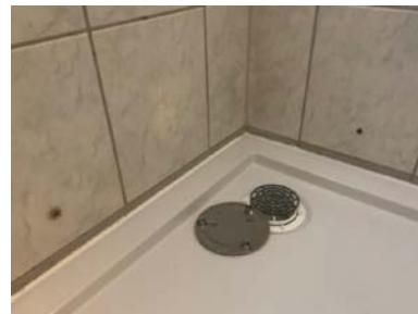
Plugg hull på vegger i dusjsone.
