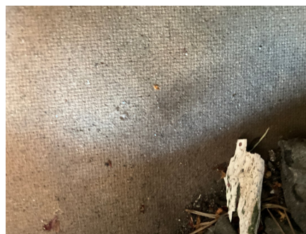
Undertak av Su-taksplater.
