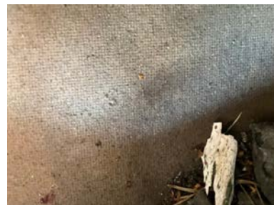
Undertak av Su-taksplater.
