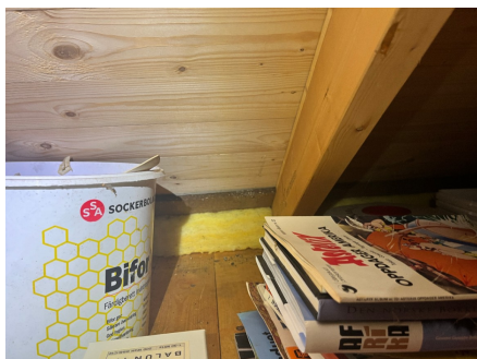
Isolert over skrå himling
