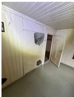
En side av teglstein pipe er delvis innkledt
