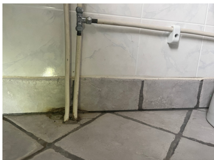
Rørgjennomføring ved toalett
