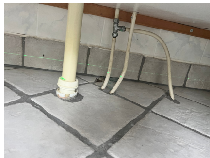
Rørgjennomføringer under servant
