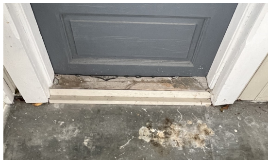
Oppbrett på sinkplater
