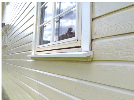
Deler av kledningen med tilhørende belistninger
