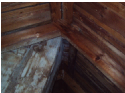
Deler av takkonstruksjonen.
