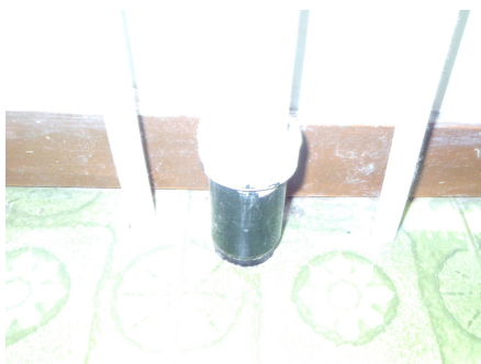
Utette rørgjennomføringer.
