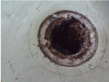
Sluke på vaskerommet
