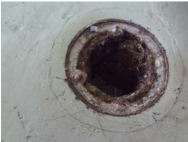
Sluke på vaskerommet
