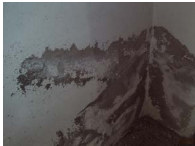
Deler av grunnmur
