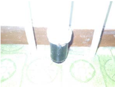
Utette rørgjennomføringer.
