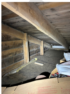
Svertesopp og manglende lufting på kaldtloft.
