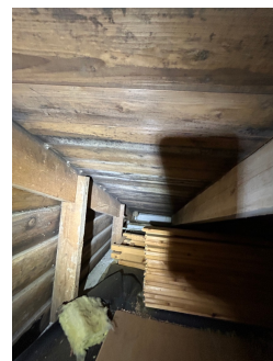
Svertesopp og manglende lufting på kaldtloft.
