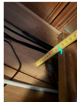
Måling med laser fra soverom mot venstre hjørne i peisestue.
