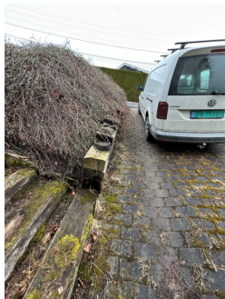
Støttemur av treverk ved garasje.
