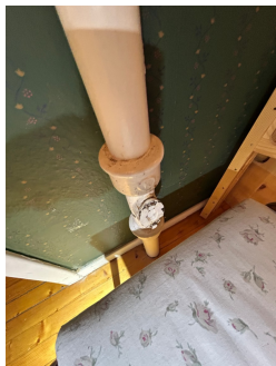
Synlig avløpsrør av støpejern i soverom i underetasje.
