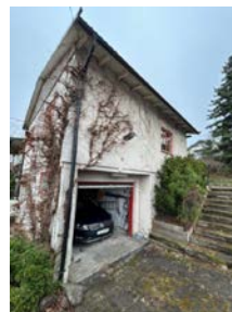
Utvendig trapp med råteskader.
