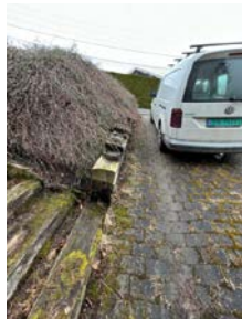
Støttemur av treverk ved garasje.
