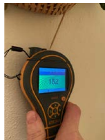
Referansesøk tatt oppunder himling i toalettrom i underetasje.
