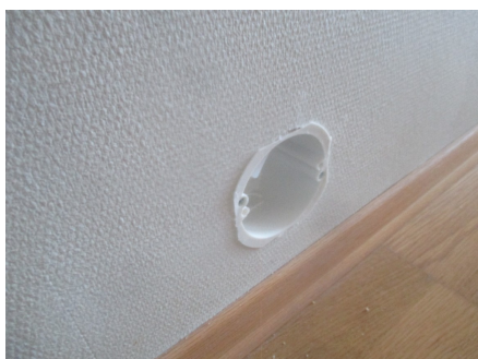
Hulltaking fra gangen.
