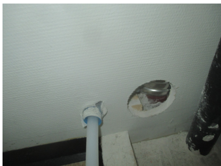
Hulltaking i fra skap ved bereder.
