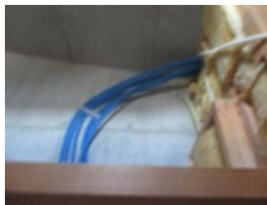
Noe synlige rør på loftet
