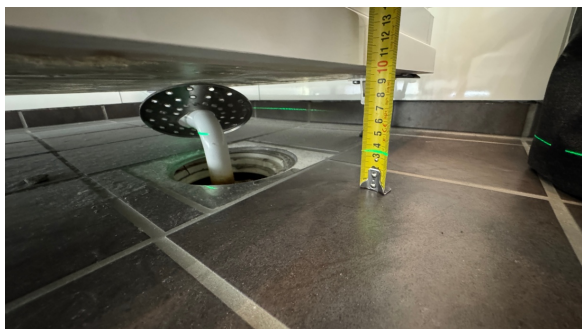
Kontroll av fallforhold.
