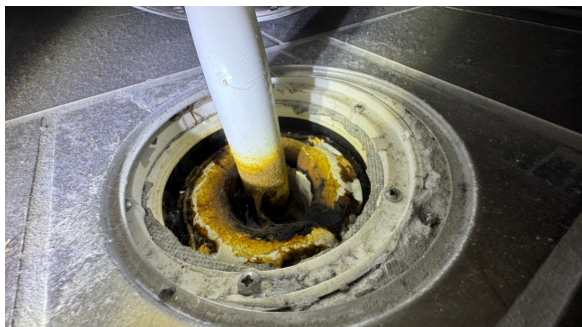
Kontroll av sluk.
