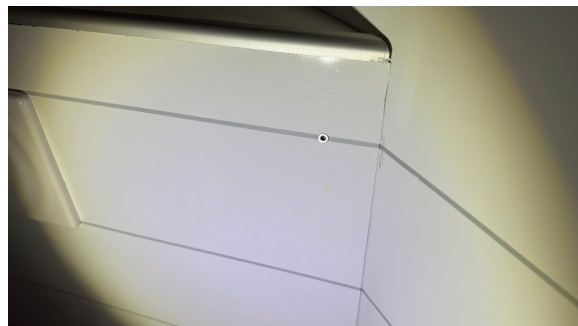
Utett utførelse av innebygget sistene.
