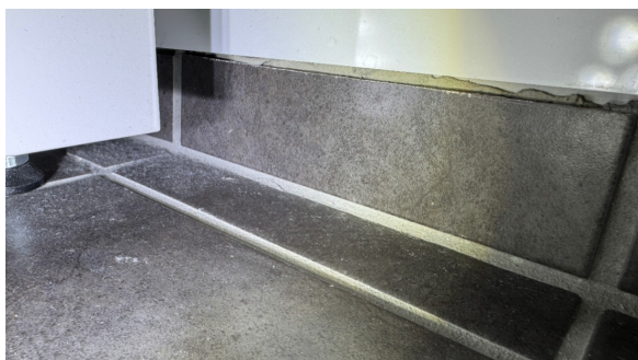
Det er benyttet tørrfug i overgang mellom gulv/vegg.
