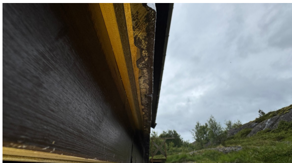
Bordkledning med luftespalter.
