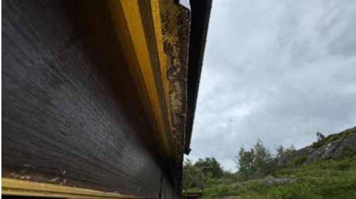
Bordkledning med luftespalter.
