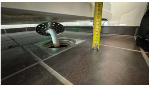
Kontroll av fallforhold.
