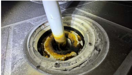
Kontroll av sluk.
