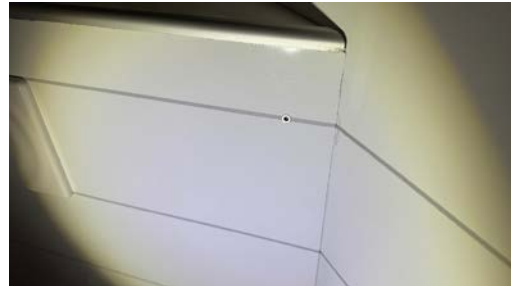
Utett utførelse av innebygget sistene.
