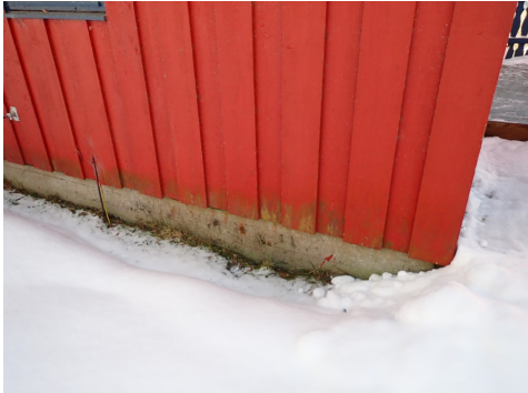
Viser mosedannelse nederst på kledning langvegg nordøst
