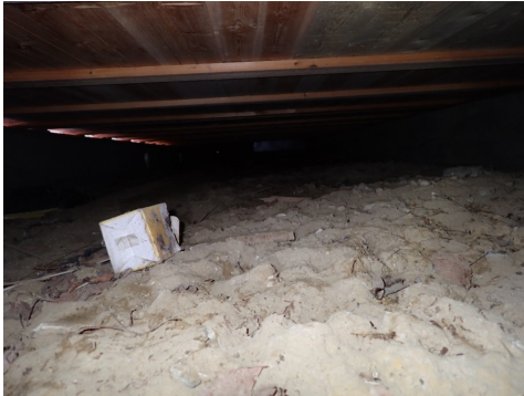
Viser krypkjeller sett fra ventilutsporing.
