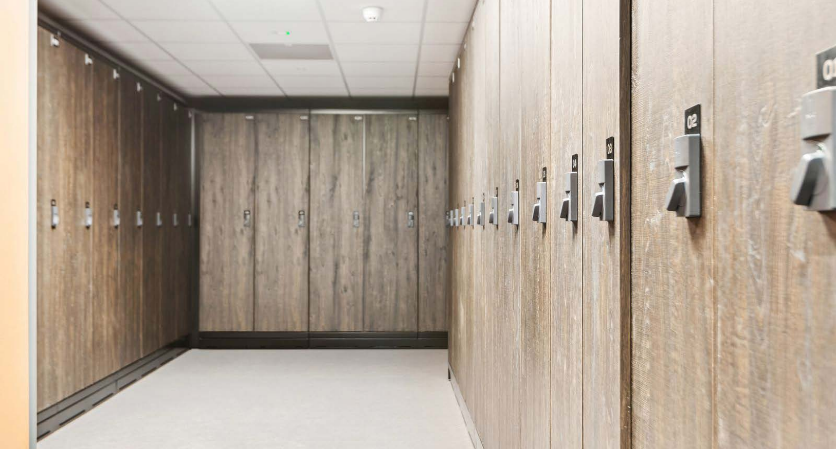
Skirom med skiskap til hver leilighet. Det er felles smørerom med inngang fra skirom.
