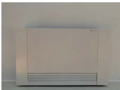
Viftekonvektor v/ himling i stue/kjøkken.
