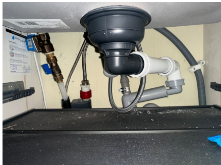
Rørapplegg i kjøkkenbenk med Waterguard
