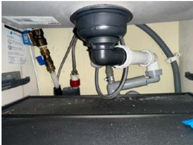
Røropplegg i kjøkkenbenk med Waterguard
