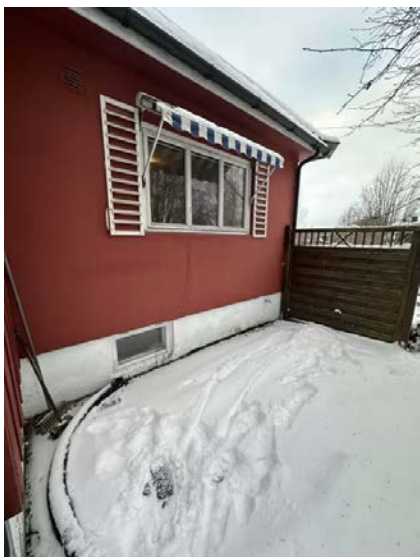
Balkong/terrasse/platting er snødekt og ikke kontrollert.
