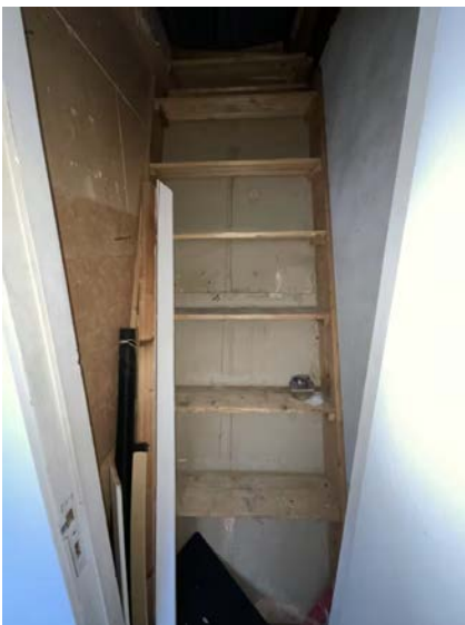
Viser trapp mellom 1.etasje og kaldtloft.
