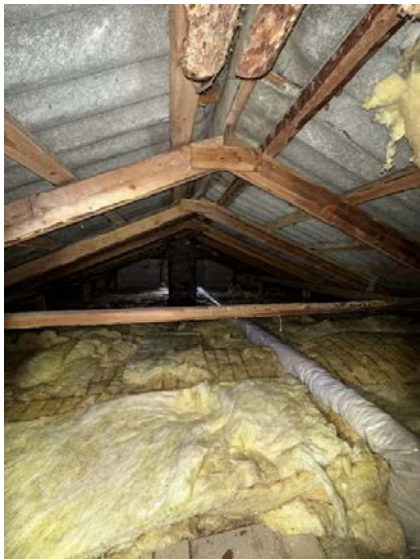
Viser loft isolert med sagflis. Etterisolert deler av loft med mineralull over sagflis.
