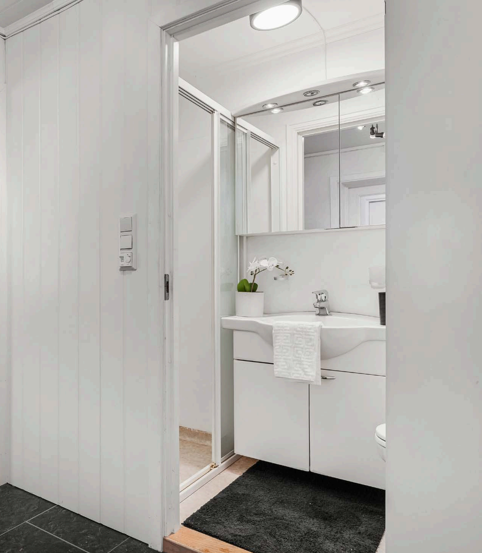
Bad med vinylbelegg på gulv og malt belegg på vegger.
