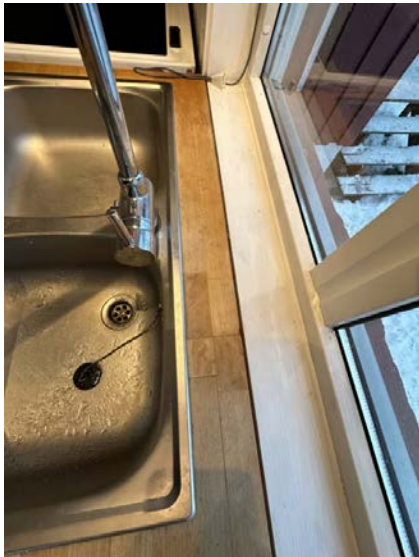
Silikonfuge mellom benkeplate og foring anbefales etablert.
