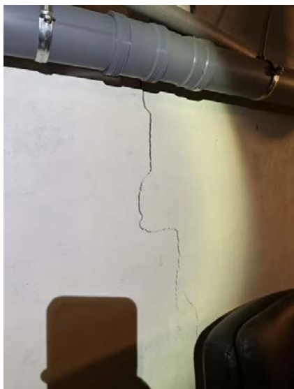
Viser skråriss i delevegg i kjeller.
