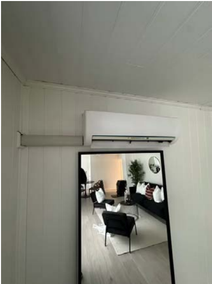
Viser montert innedel.
