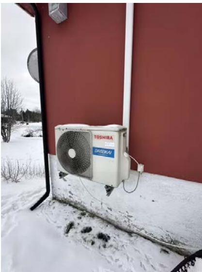
Viser luft til luft varmepumpe.
