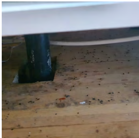
Ungen benkeskap på kjøkken
