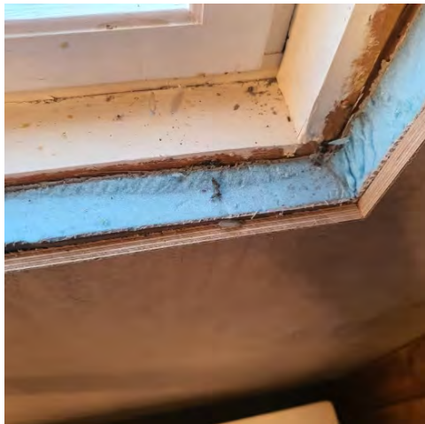
Vindu på bad.
