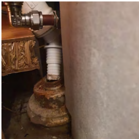
Avslutning av avløpsrør til vask på bad.
