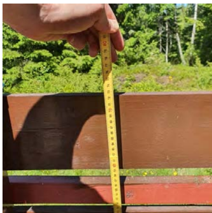
Terrasse nedenfor veranda.
