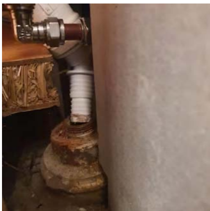
Avslutning av avløpsrør til vask på bad.
