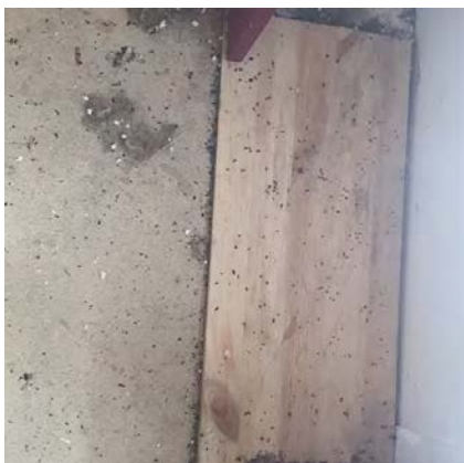
Krypkjeller rom på kjøkken
