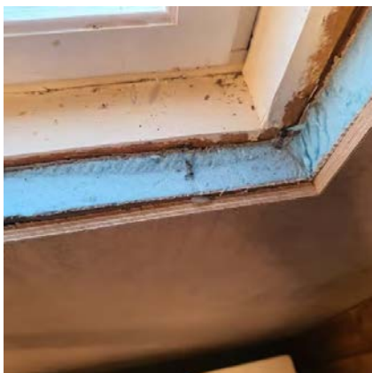
Vindu på bad.
