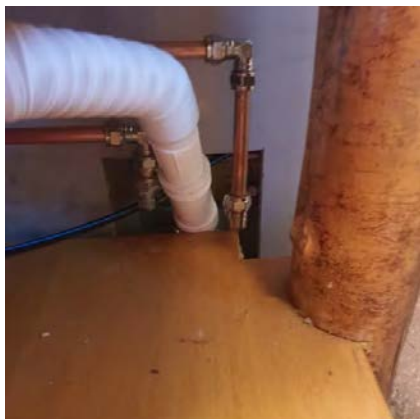
Stor utsparring i baderomsplater for rør og
