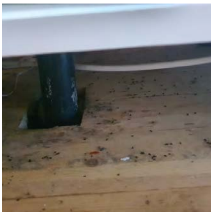
Ungen benkeskap på kjøkken
