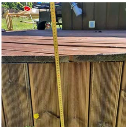
Terrasse ved inngangsparti.
