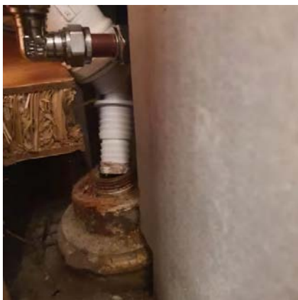
Avslutning av avløpsrør til vask på bad.
