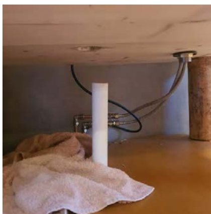
Avløpsrør vask på bad.
