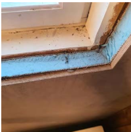
Vindu på bad.
