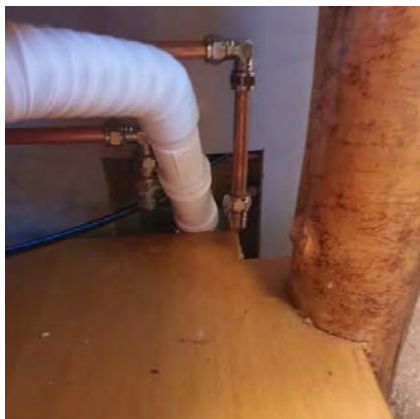
Stor utsparring i baderomsplater for rør og
