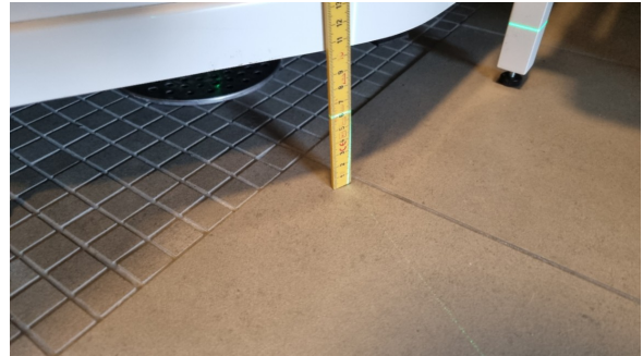
Gulvet har tilfredsstillende fall til sluk.
