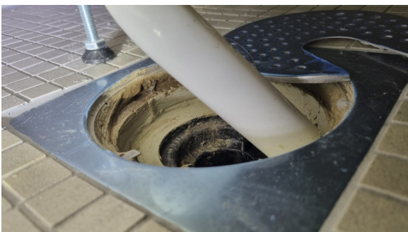
Kontroll av sluk.
