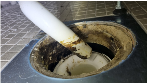
Kontroll av sluk.
