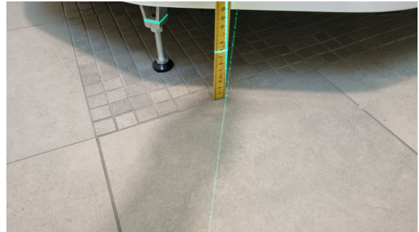
Gulvet har tilfredsstillende fall til sluk.
