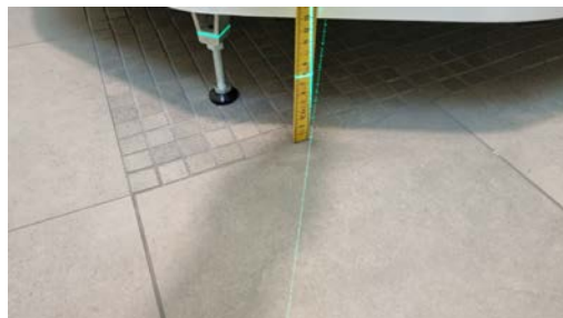
Gulvet har tilfredsstillende fall til sluk.
