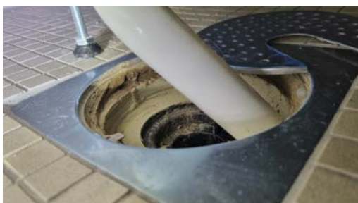
Kontroll av sluk.
