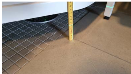
Gulvet har tilfredsstillende fall til sluk.
