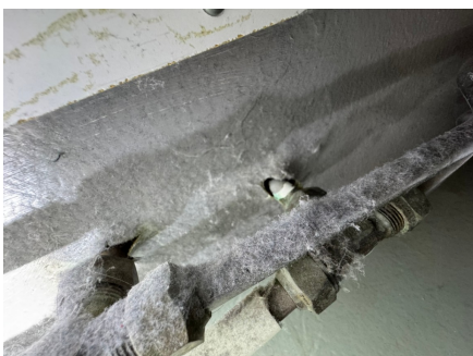
Utette rørgjennomføringer.
