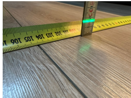
Måling av etasjeskille på kjøkkenet.
