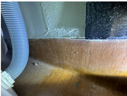
Eksempel på utettheter.
