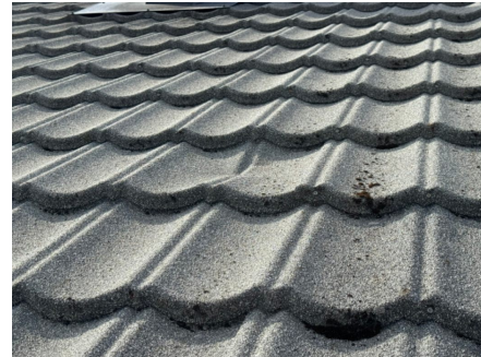
Eksempel på bulk i taktekingen.
