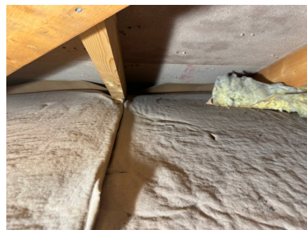
Eksempel på deformerte pappkubbinger.
