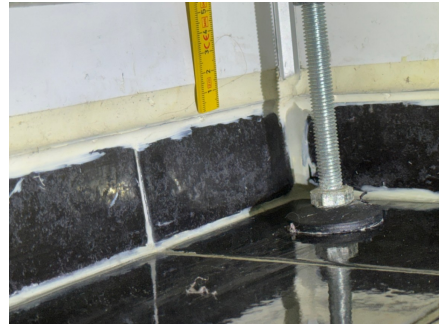
Fugemassen mellom badersplaten og bunnlisen.
