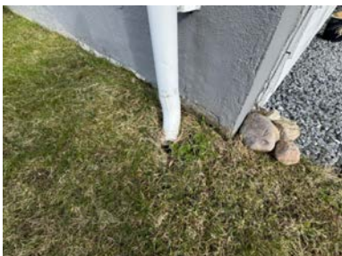
Eksempel på takrennenedløp som er avsluttet ved grunnmuren.
