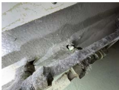
Utette rørgjennomføringer.
