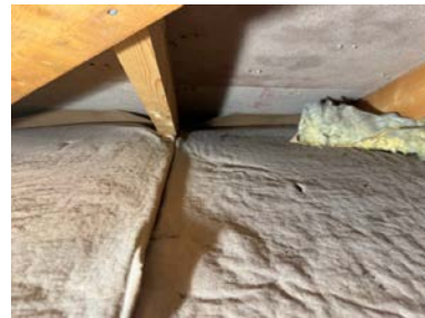
Eksempel på deformerte pappkubbinger.
