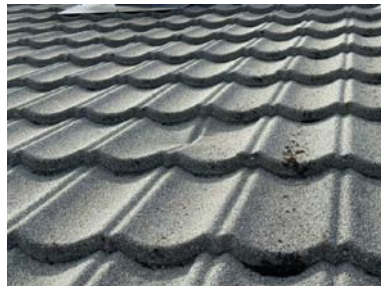
Eksempel på bulk i taktækkingen.
