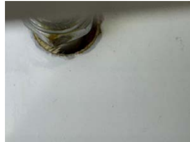
Utett gjennomgang under servanten.
