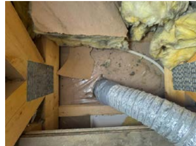
Eksempel på område som ikke er isolert.
