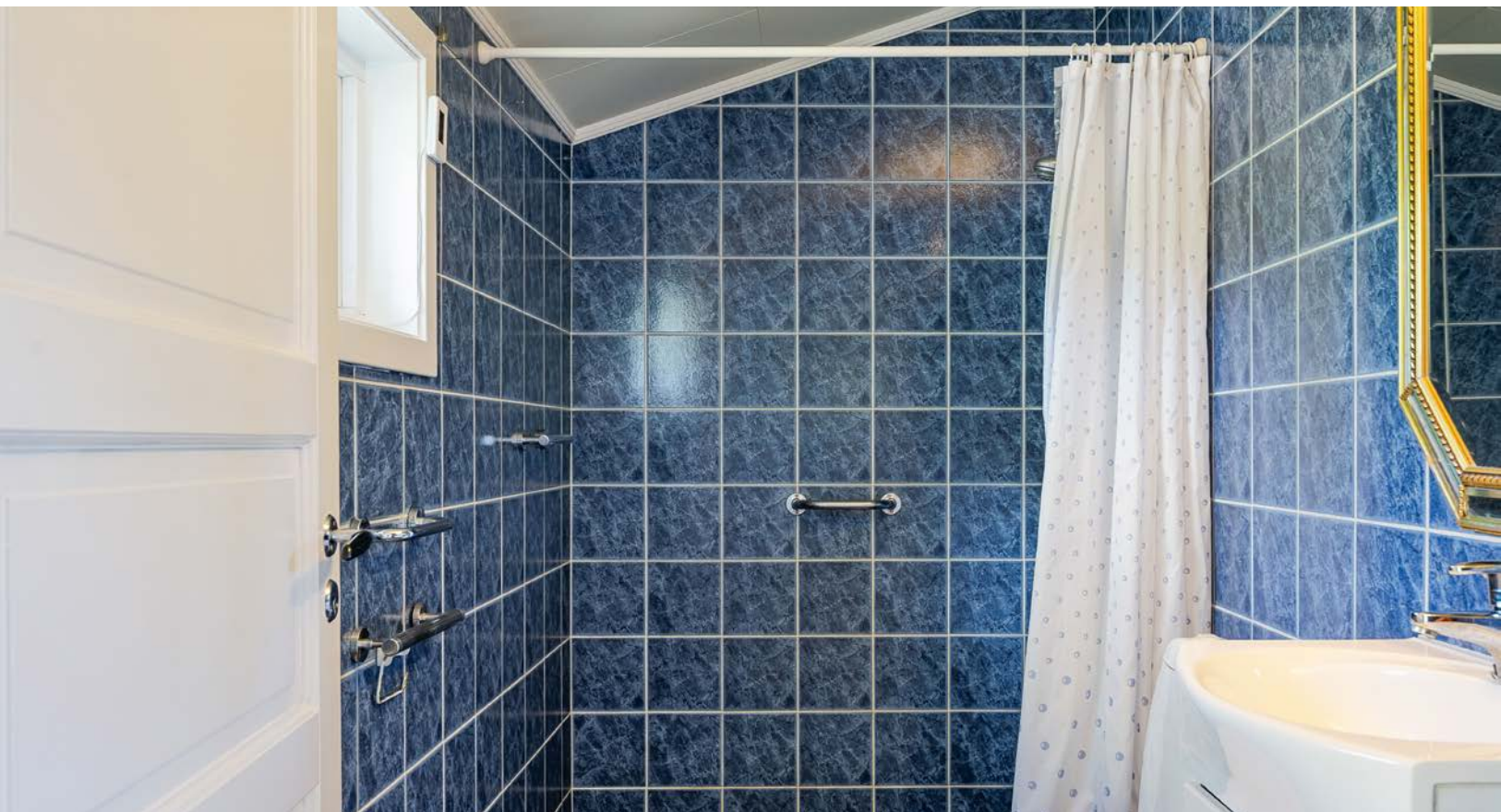
Boligen ble tilbygget med badetrom i 1. etasje i 1997. Badetrommet har blå fliser på gulv og vegger, elektriske varmekabler og et vindu med luftemulighet.
