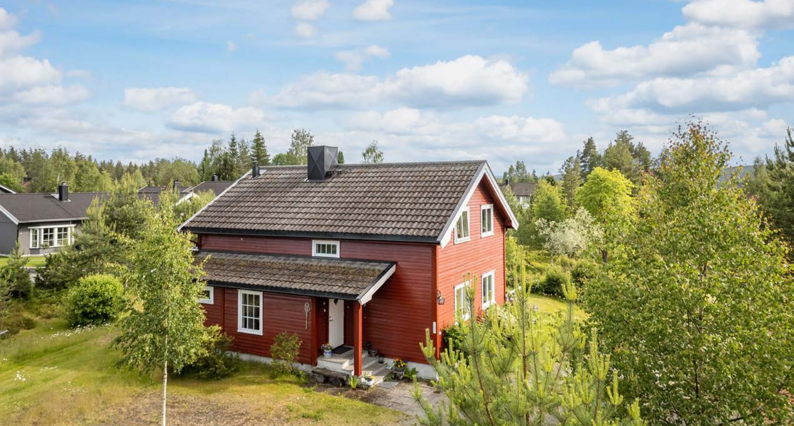
Montert panel på østveggen i 2021. Kledningen er sist overflatebehandlet i 2020. Ny takteking ble lagt i 2013.
