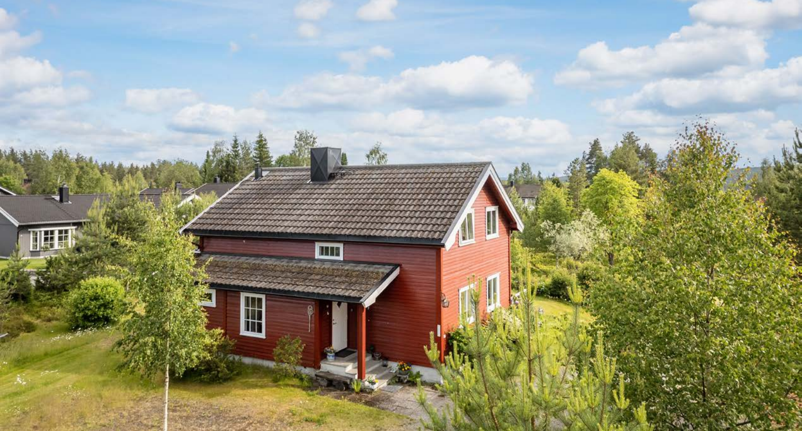
Montert panel på østveggen i 2021. Kledningen er sist overflatebehandlet i 2020. Ny taktekking ble lagt i 2013.
