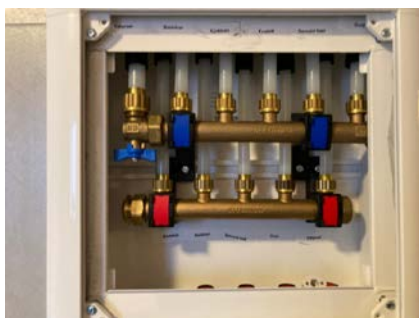
Fordelerskap for rør i rør (bad)
