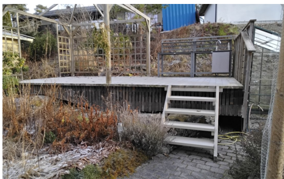
Trapp fra utvendig plattingområde.
