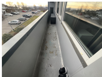
Noe løs maling på dekket.
