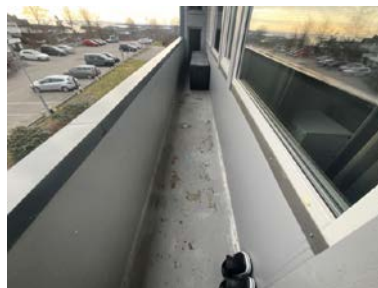
Noe løs maling på dekket.
