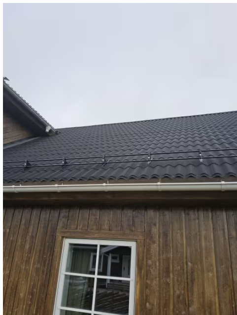
Bilde viser yttertak med snøfanger.
