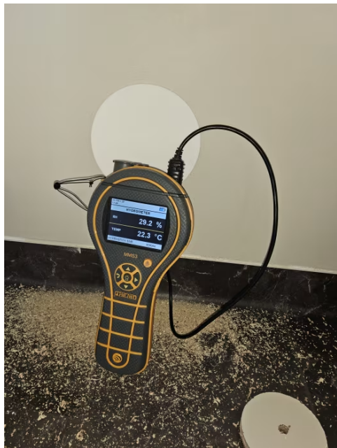
Bilde viser fuktmåling på vaskerom.
