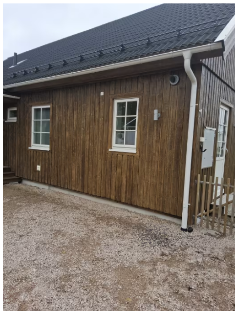
Bilde viser del av fasade mot nord.
