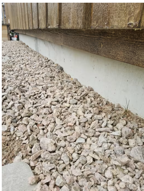
Bilde viser grunnmur.
