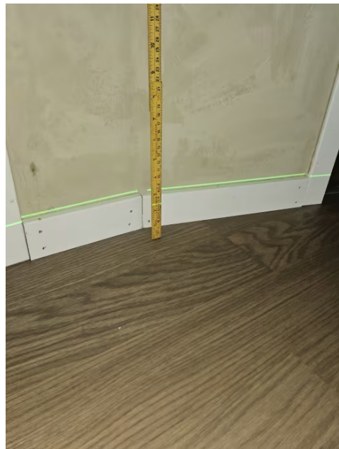
Bilde viser måling av etasjeskiller.
