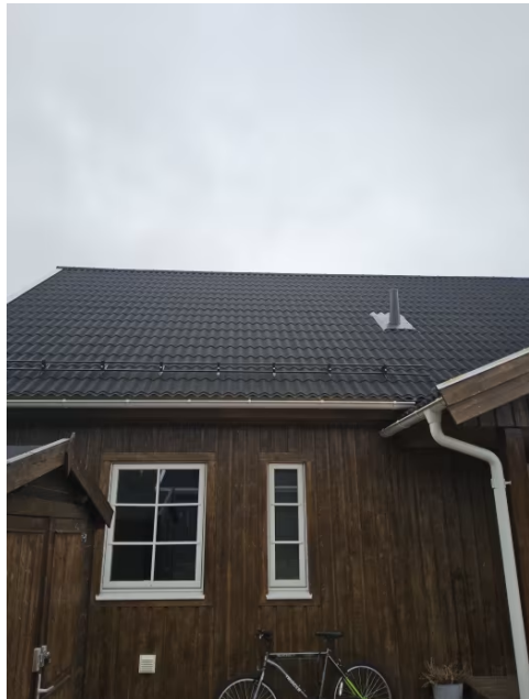
Bilde viser yttertak med snøfanger.
