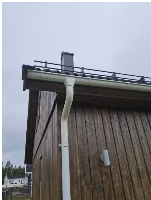
Bilde viser takrenne og taknedløp.
