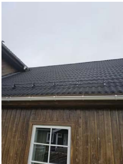
Bilde viser yttertak med snøfanger.
