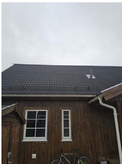
Bilde viser yttertak med snøfanger.
