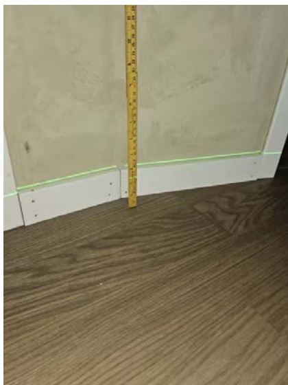
Bilde viser måling av etasjeskiller.
