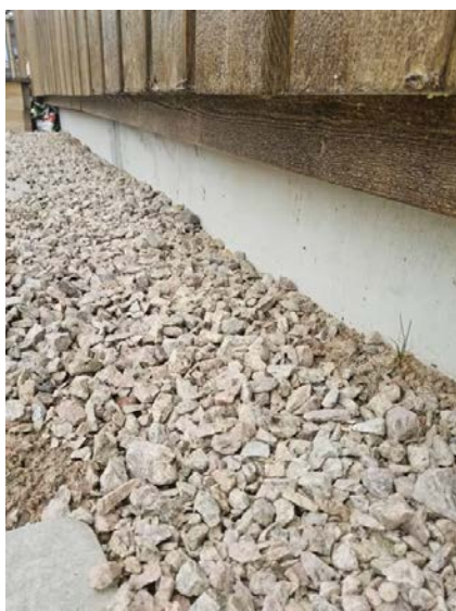
Bilde viser grunnmur.
