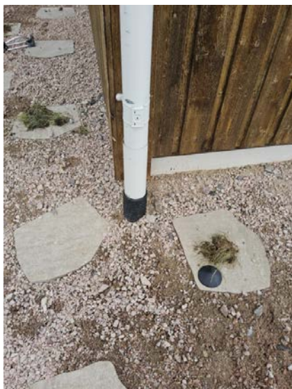
Bilde viser taknedløp ført ned i drenerør.
