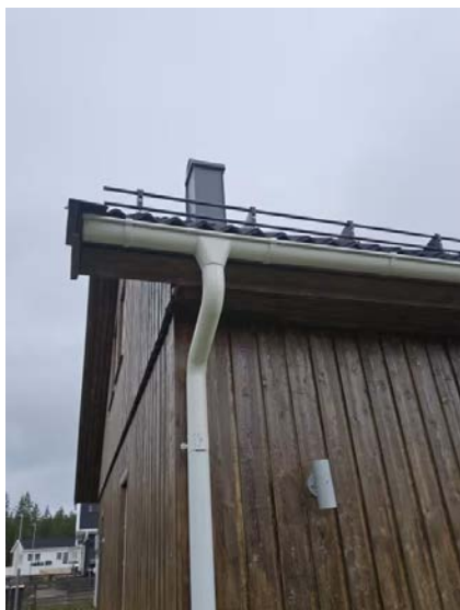
Bilde viser takrenne og taknedløp.
