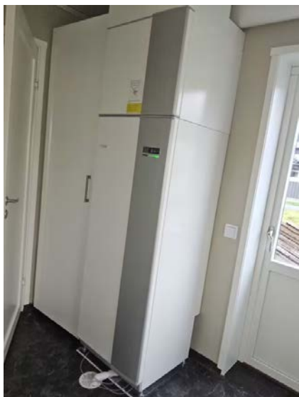
Bilde viser avtrekksvarmepumpe.
