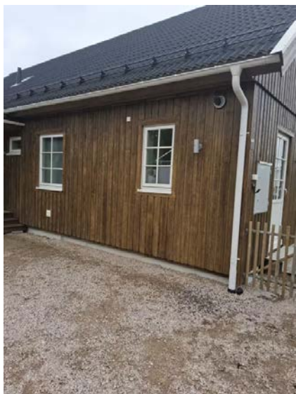
Bilde viser del av fasade mot nord.
