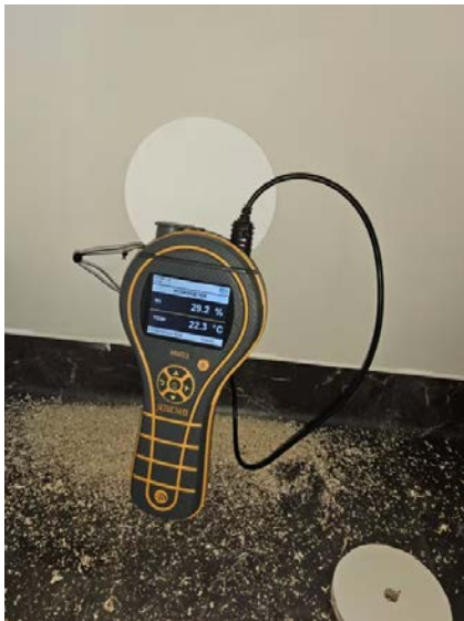
Bilde viser fuktmåling på vaskerom.
