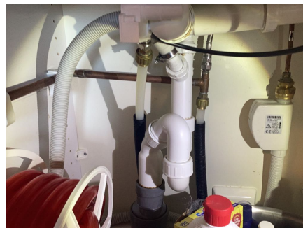
Det er ikke forsegling mellom vannrør og varerør på kjøkken.
