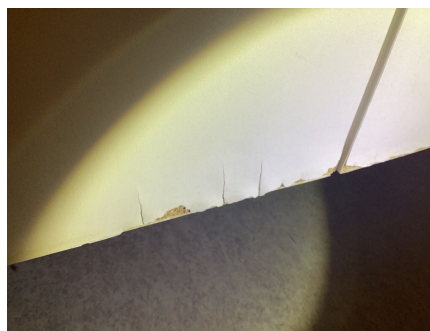
Kraftig slitasje på fronter på servantinnredning.
