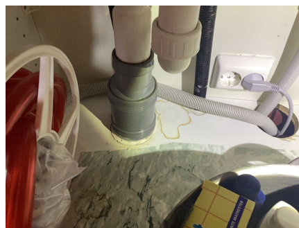
Fuktmerker under vask. Bør følges med på.
