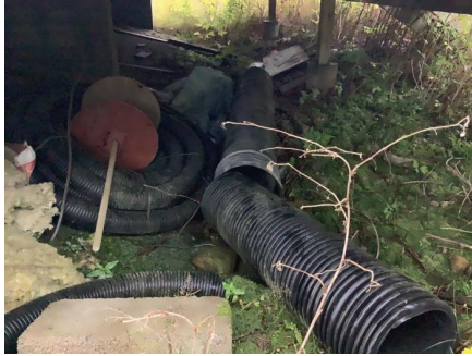
Utilfredsstillende fall fra bygning.
