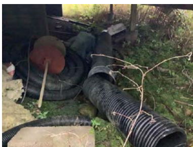
Utilfredsstillende fall fra bygning.
