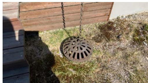
Nedløp fra kjetting til infiltrasjon.
