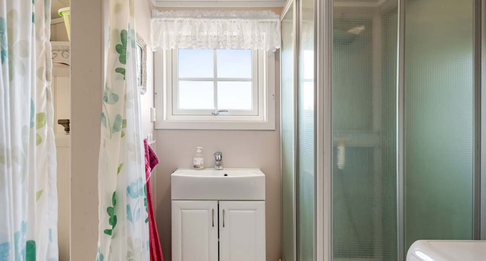
Badet ble etablert i forbindelse med tilbygg omkring 2008. Her er det gulvbelegg og baderomsplater på veggene. Dusjkabinett, servant og opplegg til vaskemaskin.
